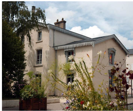
Figure 3: Rammed earth house - La maison Gueffier à La Roche-sur-Yon
